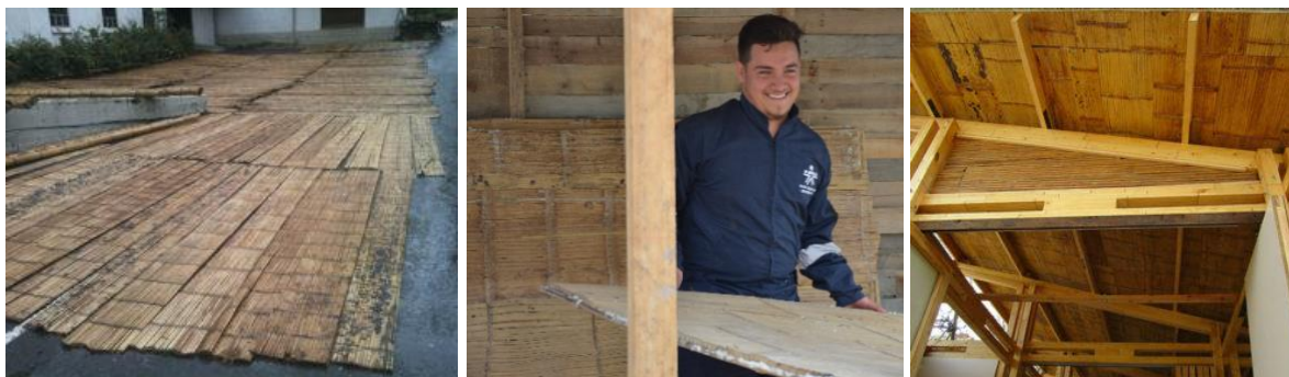
Figura 1. Tableros de esterilla utilizados para la elaboración de los laminados (izquierda). Proceso de elaboración de los tableros (centro). Laminados utilizados en el cielo raso del proyecto Universidad La Salle - Solar Decathlon 2015 (derecha).
