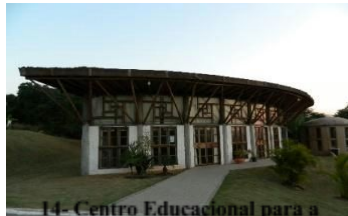
14- Centro Educacional para a Sustentabilidade - Alphaville Arq.: Marcelo Todescan, Frank Siciliano Construcción: [bambu]: Robert Harris Local: Santana de Parnaíba, SP-2008
