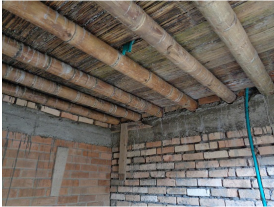
Fotografías 7 y 8. Losa en vivienda particular, 2000.
